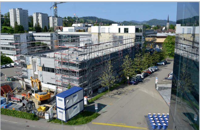
Bild: Ostflügel des SIP während der Aufstockung
