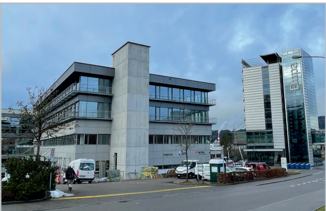
Bild: Ostflügel des SIP nach der Aufstockung
