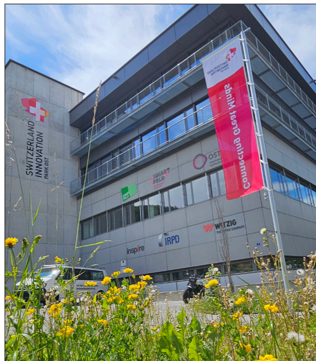
Die Aufstockung des Ostflügels wurde im Berichtsjahr fertig gestellt.
