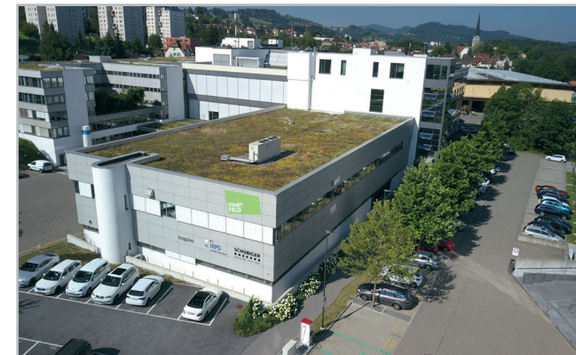
Bild: Ostflügel des SIP Ost vor der Aufstockung
