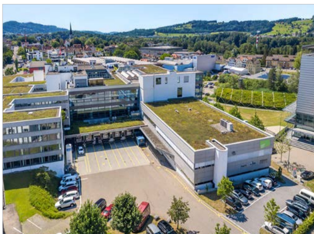
Campus des SIP Ost an der Lerchenfeldstrasse in St.Gallen.
